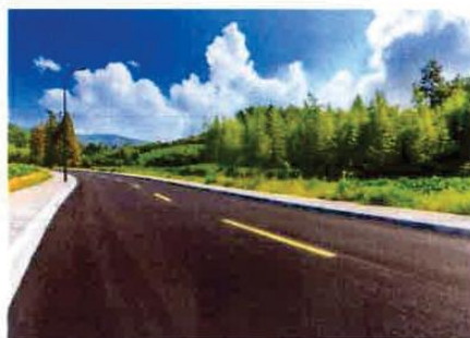
FIGURA 6 - VIA RODOVIÁRIA EM ZONA PLANA
