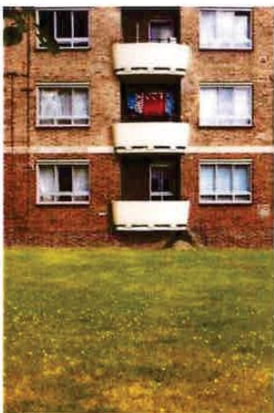
FIGURA 20 - CONSTRUÇÃO COM VARANDA
