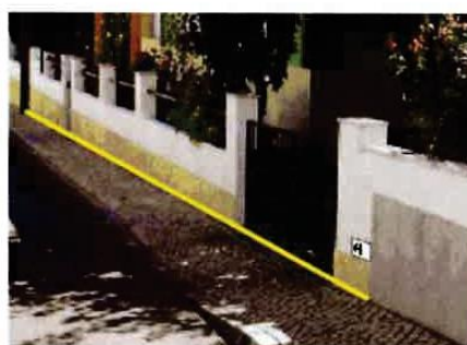
FIGURA 17 - PRÉDIO DELIMITADO POR MURO PERTENCENTE A UM SÓ PRÉDIO
