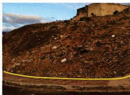
FIGURA 2 – DELIMITAÇÃO DE PRÉDIO JUNTO A TALUDE NATURAL
