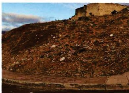
FIGURA 1 - PRÉDIO JUNTO A TALUDE NATURAL
